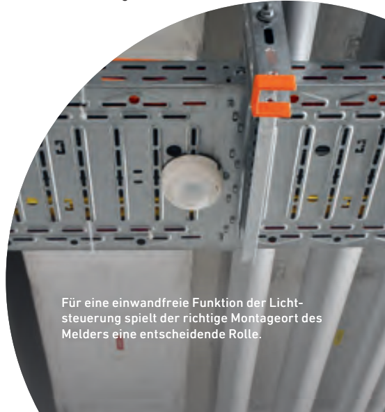
Abb. 1: Ein PIR- Melder schaltet bei seitlichem Vorbeigehen, bedeutend früher als bei direktem Draufzugehen.
